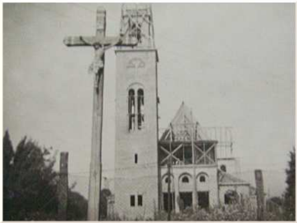
Nasz kościół parafialny w budowie
